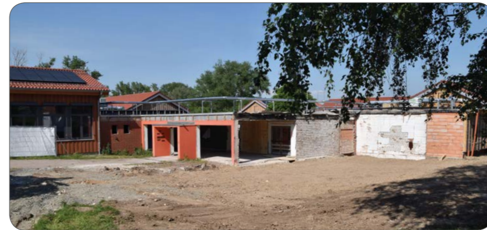
Der Abriss des alten Schulgebäudes ist geschafft!
